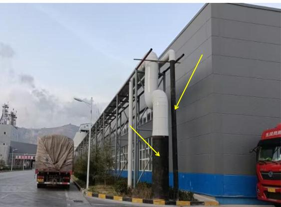
供汽管道（左）、冷凝水回水管道（右）
