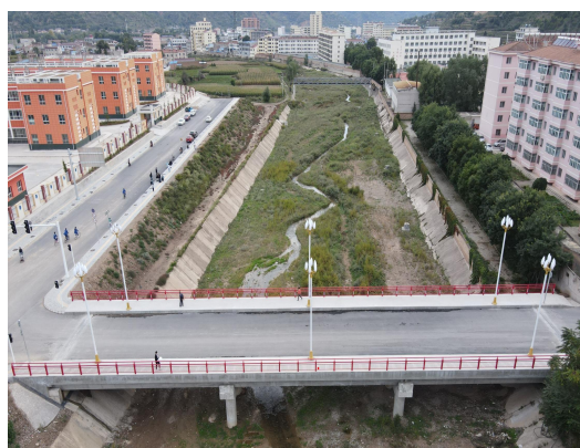
桥梁全貌及引道图
