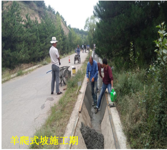
羊爬式坡排水边沟施工
